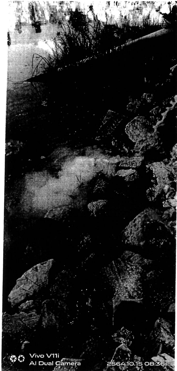
ภาพที่ 3.1 การผสมปูนขาวกรนกับน้ำทะเลในบ่อดักตะกอนในชุมชนเมือง
